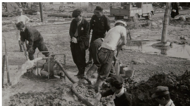
本管復旧作業
