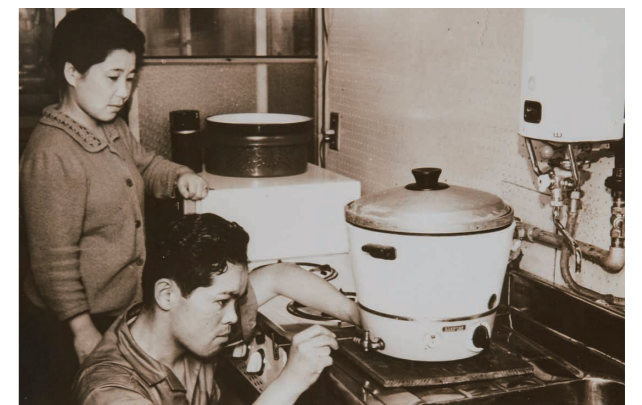
お客さま宅でのガス器具調整作業
